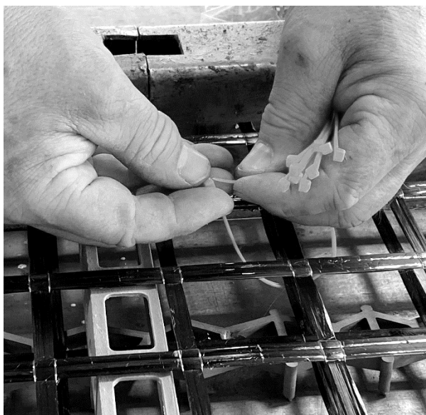
Abbildung 17: Binden von Bewehrungen mit Kabelbindern
