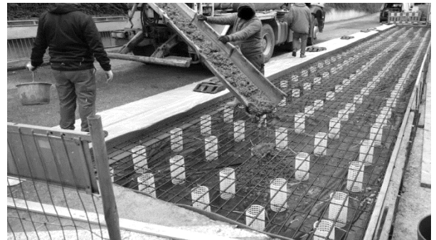
Abbildung 16: Kunststoff-Filterrohre als Unterstützungen für ein metallfreies Bauteil
