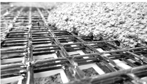
Abbildung 20: Flächige Auflagerung von Bewehrungsgittern mithilfe von Gittern als Abstandhalter
