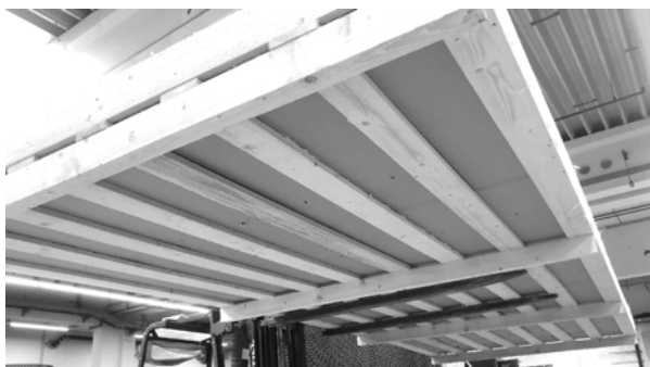
Abbildung 9: Palettentransport für ebene Bewehrungsgitter
