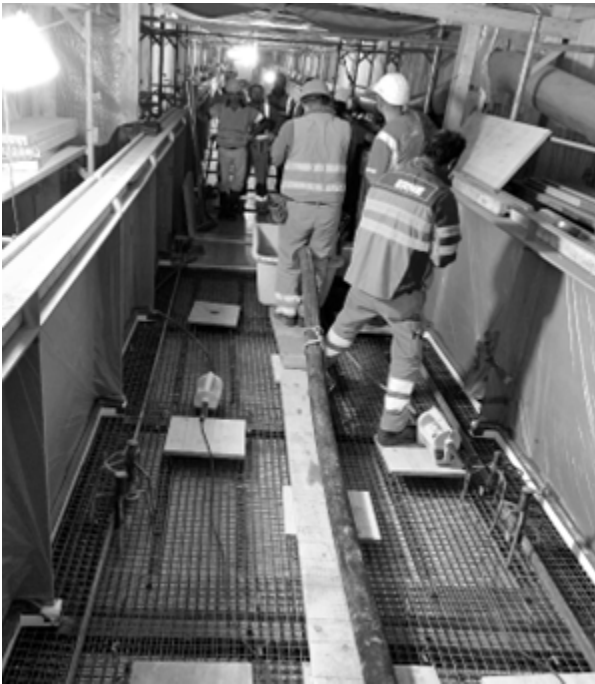
Abbildung 19: Begehungshilfen zur Vermeidung des direkten Begehens von Bewehrungen aus Faserverbundwerkstoffen
