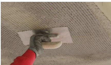
Die Wellenbildung an der Textilkante deutet auf eine nicht optimale Positionierung beim Einstreichen der Bewehrung hin. © C³Verband
