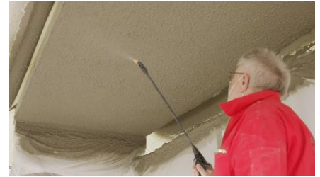
Die Nachbehandlung der Oberfläche ist wegen der dünnen Materialstärke besonders wichtig.
