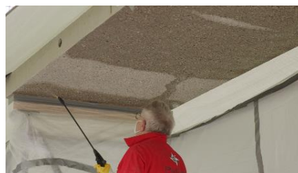
Letztes Mal Vornässen bevor die Verstärkung durchgeführt wird. © C³Verband
